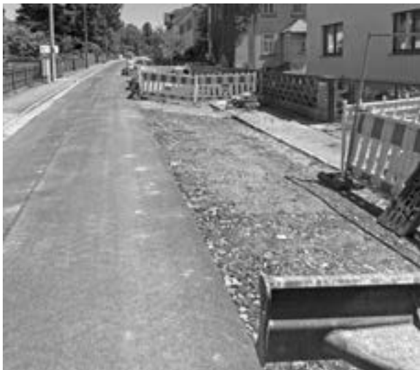
Baumaßnahme Stiehlerstraße Langebrück
